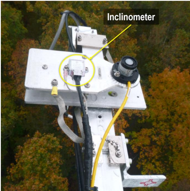
Figure 50. Inclinometer on the PAR Quantum Sensor Leveling Plate (D08 DELA)
